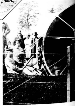
Este aparato inventado recientemente, ha dado excelentes resultados de su utilización. La concha percibe a distancia las menores vibraciones.
